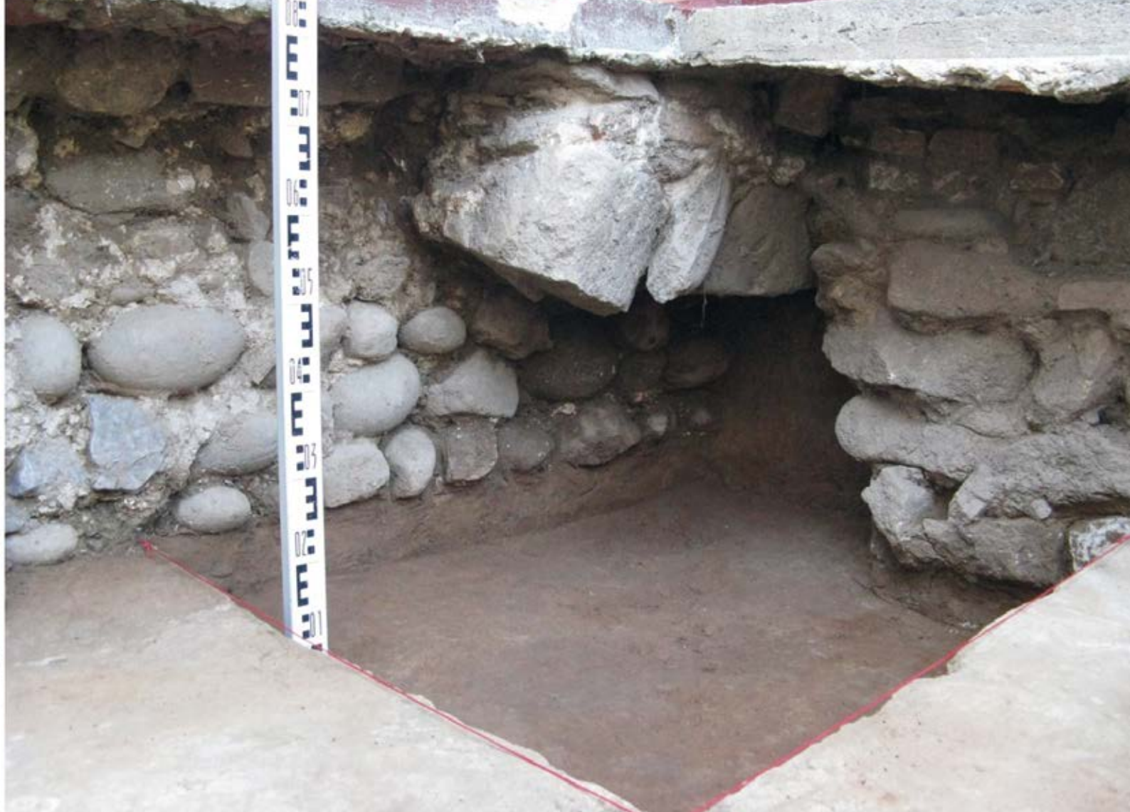
9. Sondagem 2: vista geral do plano final da intervenção e pormenor das fundações dos edifícios.
