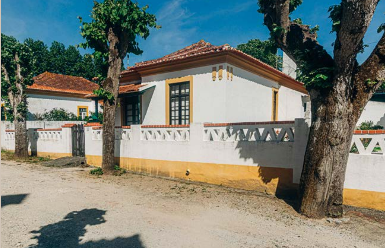
3. Casa do bairro da Vista Alegre, 2023. Fotografia do autor
